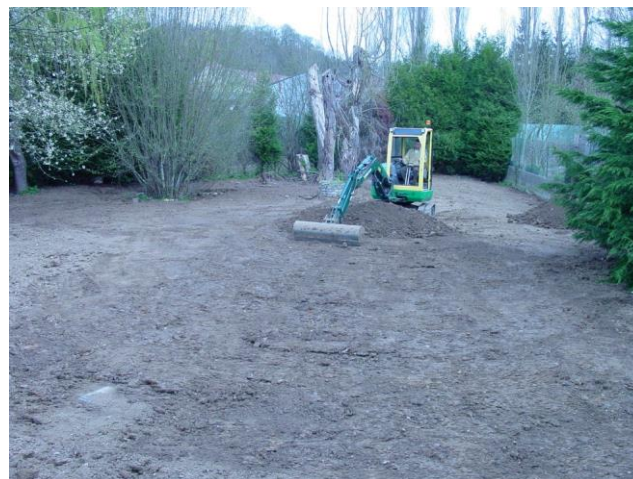
Mise en forme des terres d'apport
