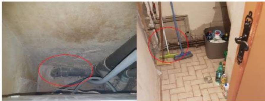
Cellier : Pénétration des évacuations
