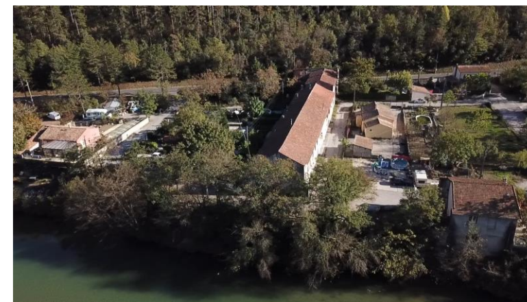
... reconvertie en habitations
