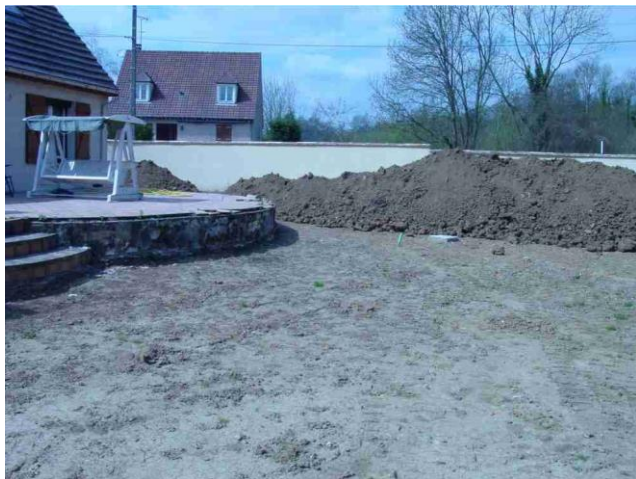
Décaissement de terres polluées
